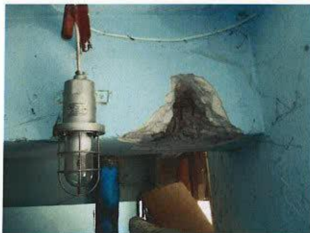
Снимка № 8 - Разрушен участък на стоманобетонна греда в абонатната станция
