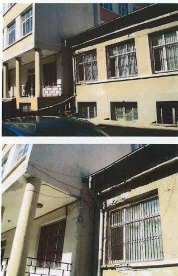
Снимки № 14 и 15 - Повреди от течове на водосточната тръба
